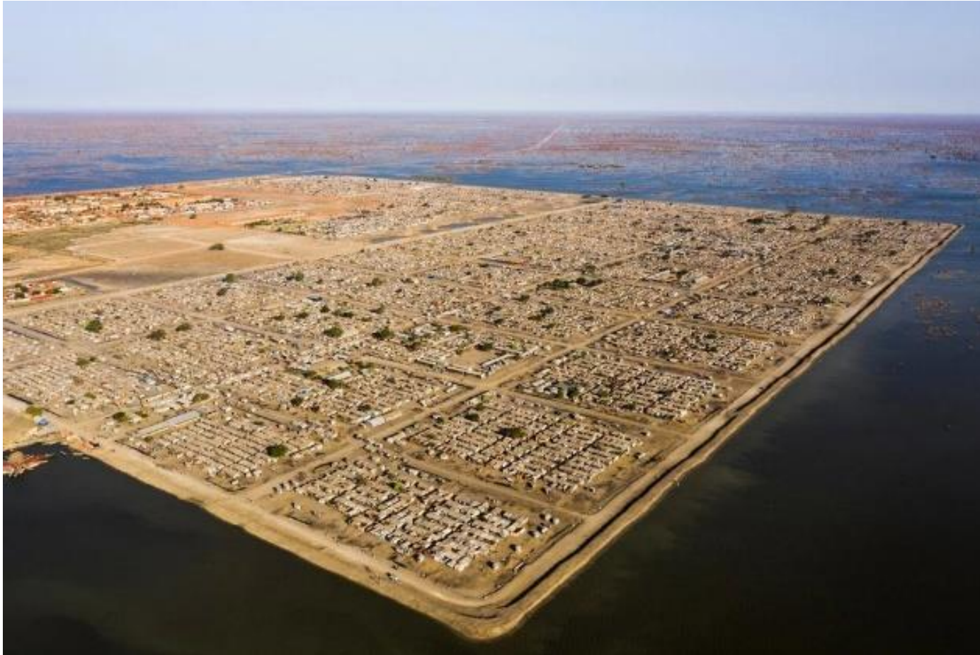
Figure I Camp de déplacés de Bentiu, actuellement une masse terrestre isolée, entourée de terrains inondés et protégée par des digues
